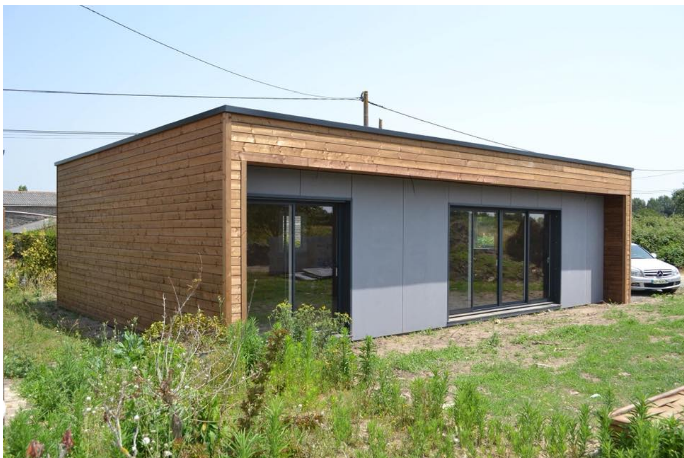
Pose terminée de la maison en bois préfabriquée
