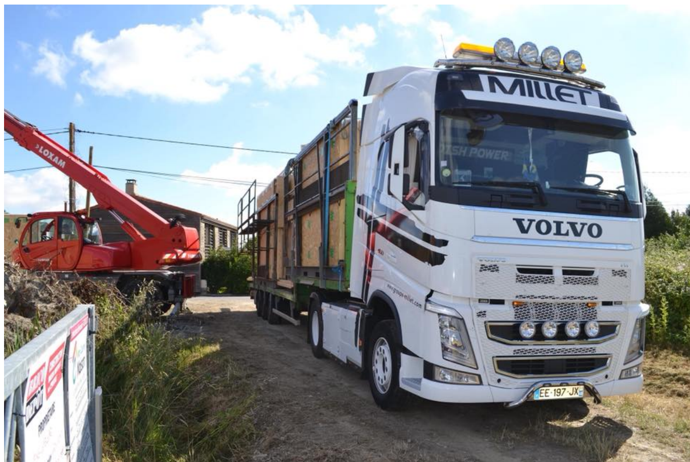
Arrivée du camion Millet avec les panneaux en bois et les ouvertures
