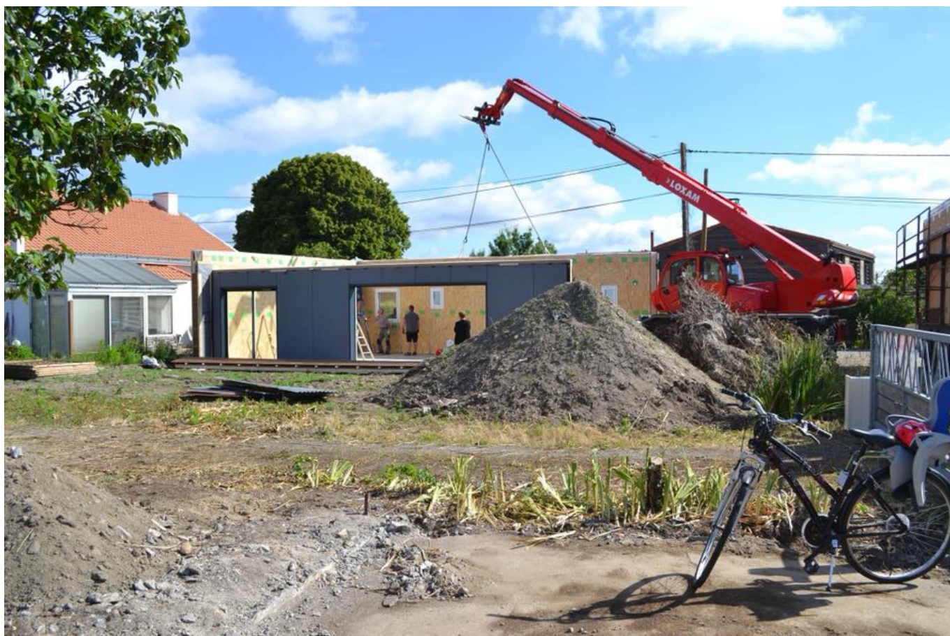
Pose des panneaux préfabriqués en ossature bois
