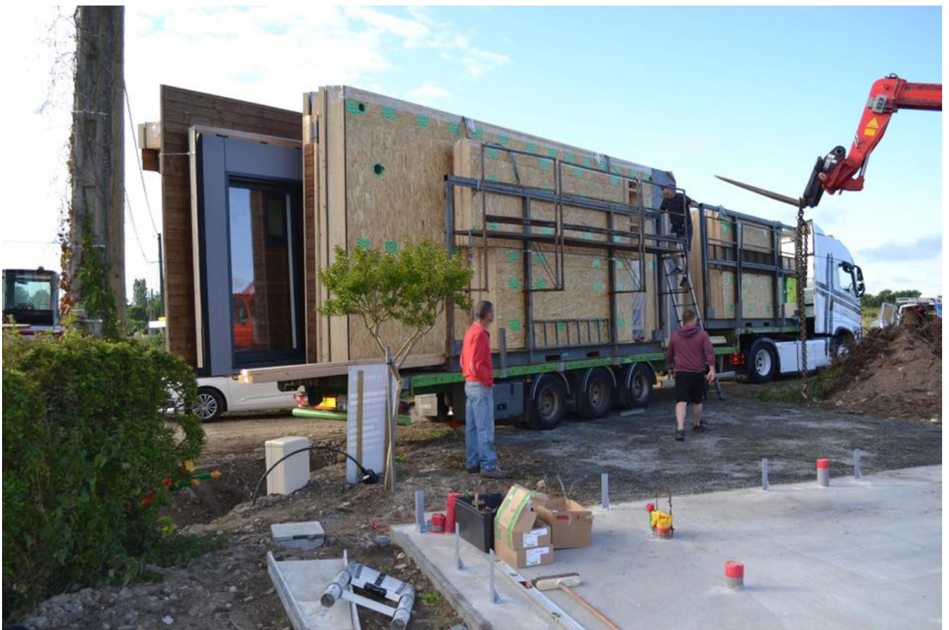
Dalle béton réalisée par une entreprise locale avant la pose des panneaux en bois
